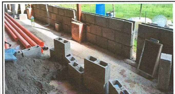
Foto 3: Colocación de block para el muro del corredor.
