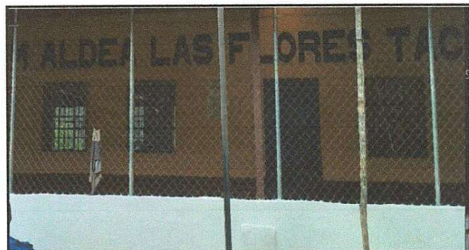
Foto 6: Instalación de malla y repello del cerco.
