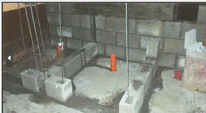
Foto 2: Levantado de los dos baños.
