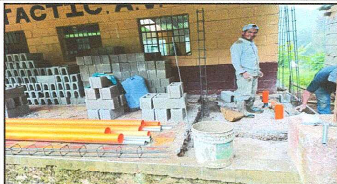
Foto 1: Levantado de la estructura del cerco del corredor y baño.
