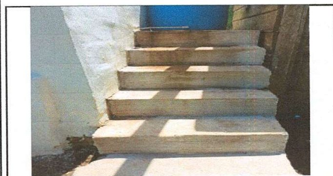
Foto 5: Elaboración de bases para el sistema de agua.
