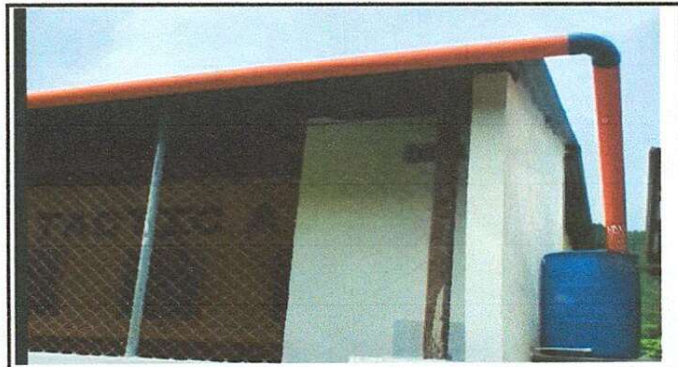
Foto 4: Instalación de sistema de agua para inodoro y lavamanos.
